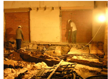
Eliminació parcial murs sala1
