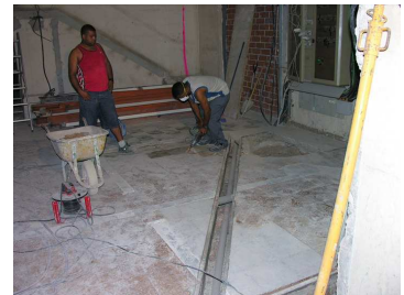
Inici treballs sala2
