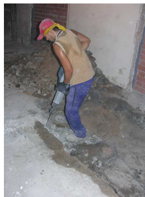
Inici treballs sala1
