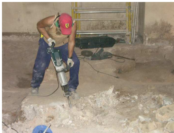
Eliminació parcial UE1024
