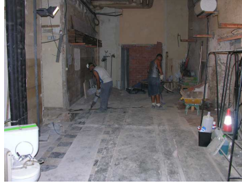
Inici treballs sala3
